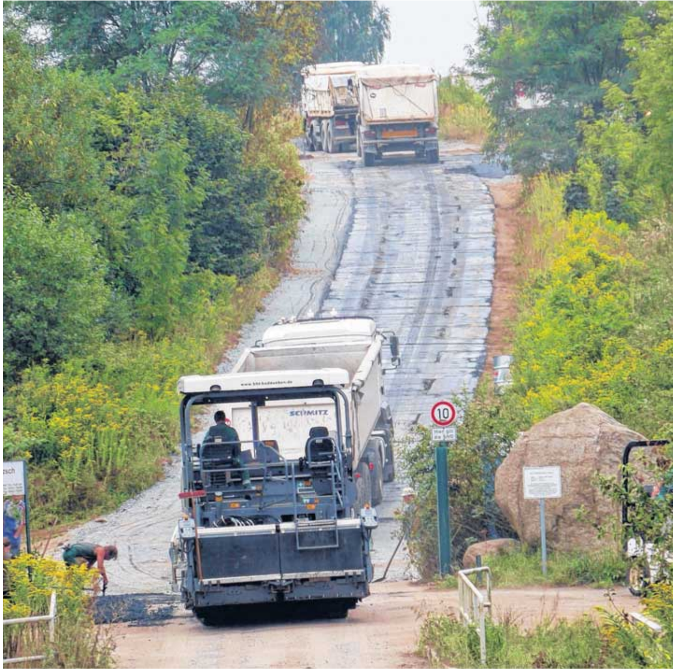
Die Bad Dübener Bau- und Haustechnik legt dieser Tage die Ausweichstraße parallel zur B 107, zum Teil auch über das Betriebsgelände der Kiesgrube Grotzsch an. Fotos: Heike Liesaus
